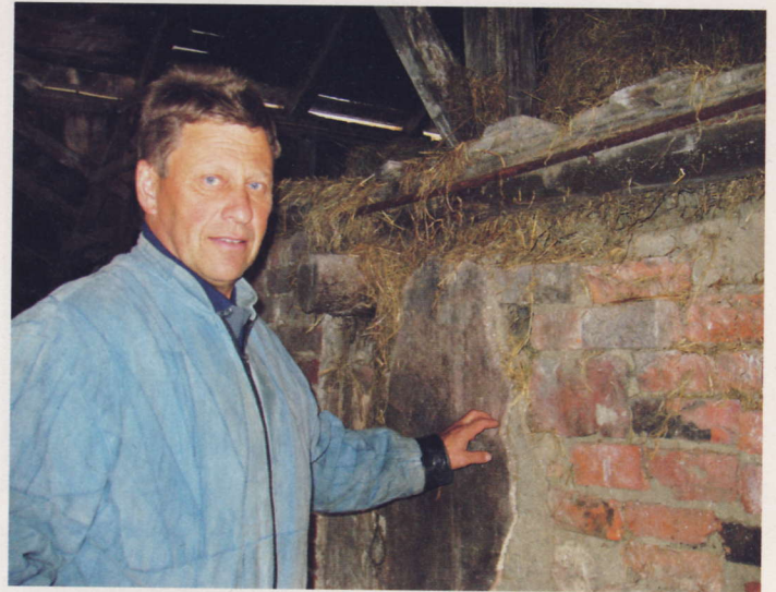
▲ Vesa Riihihuhta osoittaa alkuperäistä savirappausta. Savirappausten vaaleanpunertava väri saattaa johtua häränverestä. Entisen ikkunan kohdalla näkyy vanhaa tiiliseinää.
