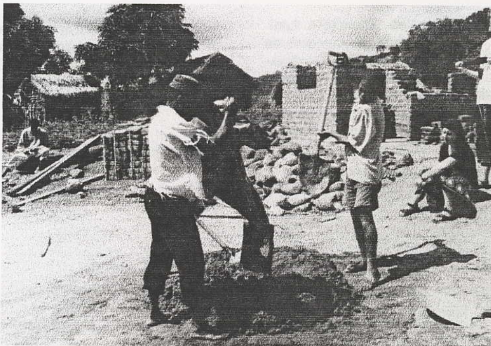
Laastia sekoitetaan maassa. Taustalla näkyy terveyskeskustyömaa.
