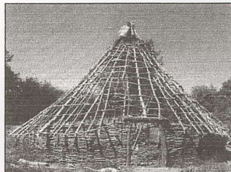
Rakennus ilman katetta
