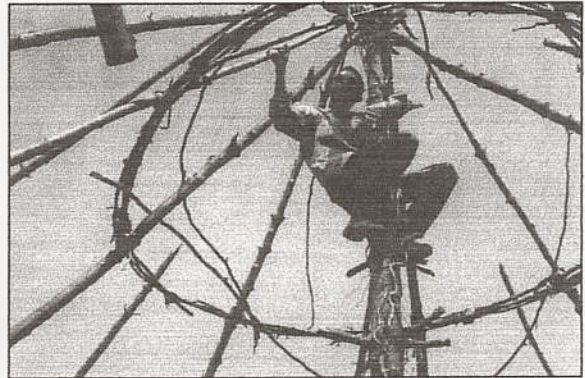
Keskitolppa poistettiin kattokehikon valmistuttua
