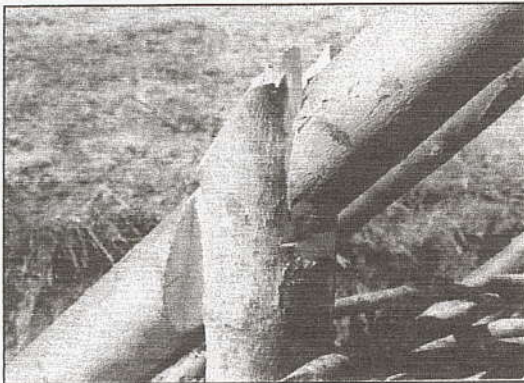
Kattotuolin ja seinätolpan tapitus
