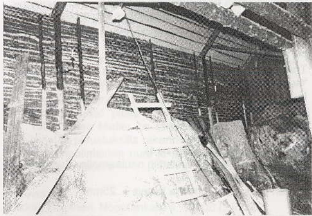
Valmista seinäpintaa. Pieniä aloja on tarkoitus rapata myöhemmin. Rapattuihin kohtiin tullaan maalaamaan tunnelmaan sopivia koristeita.
