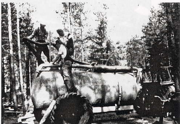
Kyösti Kangas ja kirvesmiehet Veijo Palosaari ja Kimmo Nissinen sekoittamassa savilietettä lietelannan levityskärryssä. Kerta-annos n. 1000 litraa.
