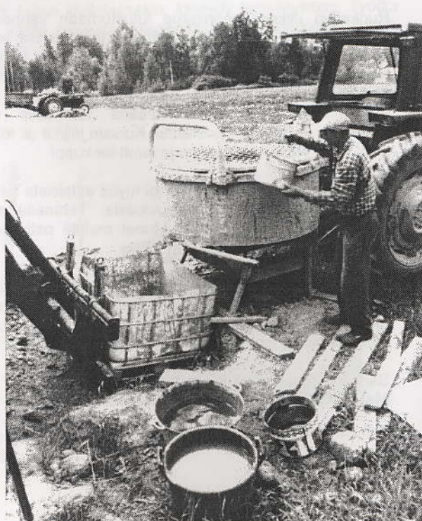
Savilietteen sekoitusjärjestelyt. Liete sekoitettiin vaakatasosekoittimessa, josta se tyhjennettiin isoon muoviasiaan sekoittimelle kuljetusta varten.
