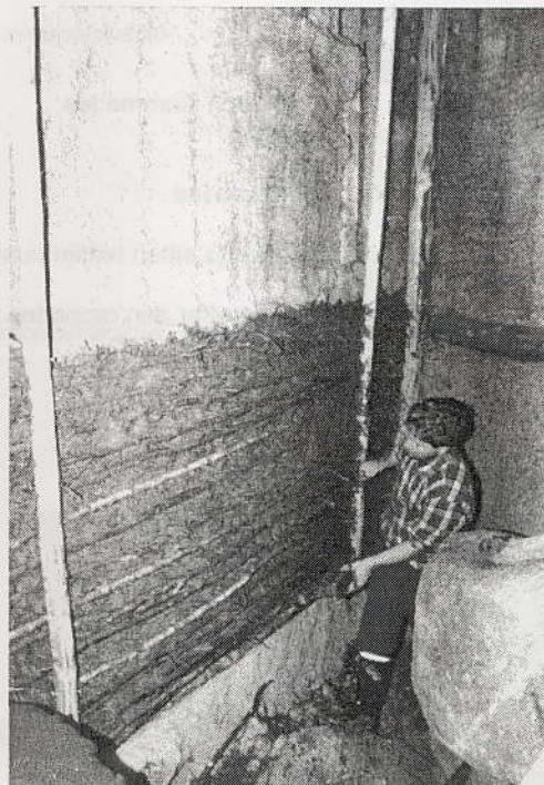
Seinäpintaa saadaan tehtyä sileämmäksi harjaamalla sitä tuoreena riukujen suuntaisesti. Jounin Taivainen harjaa seinäpintaa. Louhenlinna, Laitila 22.10.1999
