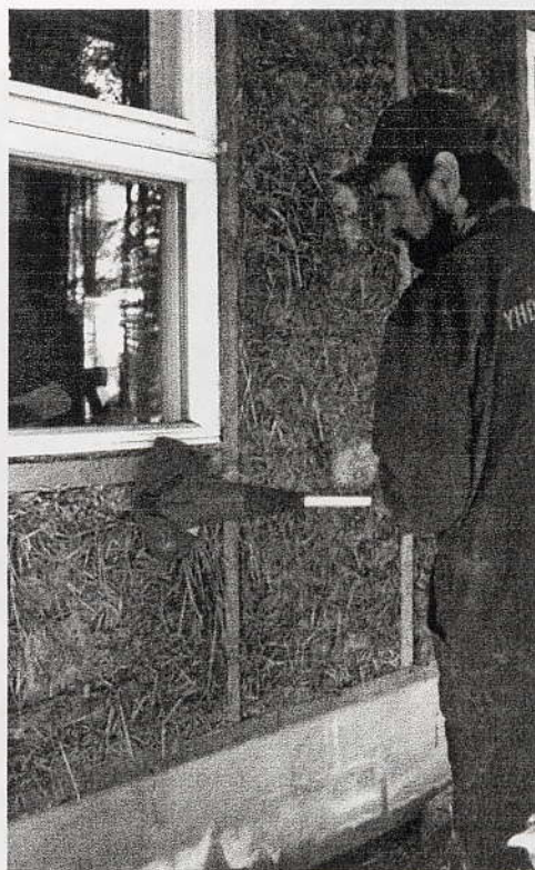
Saviseinään syntyneet vajoamat, esim. ikkunoiden alla, tilkittiin juntaamalla kuivaa olkea rakoihin. Olkitupperoita trimmaamassa nurmikonsiistijällä Kyösti Kangas.
