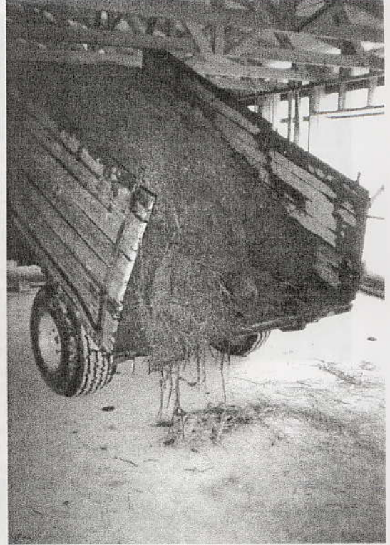
Valmis savimassa tuotiin traktorin peräkärriissä sisälle taloon, josta se oli helppo työstää seiniin.
