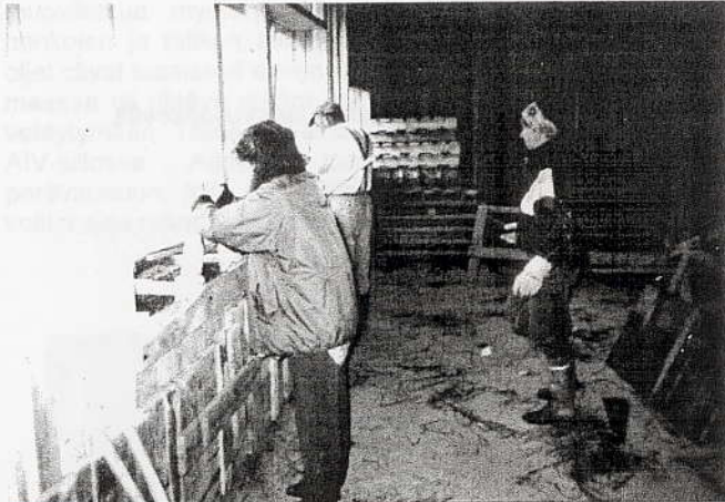
Valutyö käynnissä. Muotteina käytettiin laudoista tehtyjä muottilevyjä.
