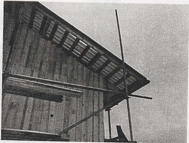
Mallikelpoinen räystään mitta ja pystyauoitus suojaamassa saviseinää. Helmikuu 2000.
