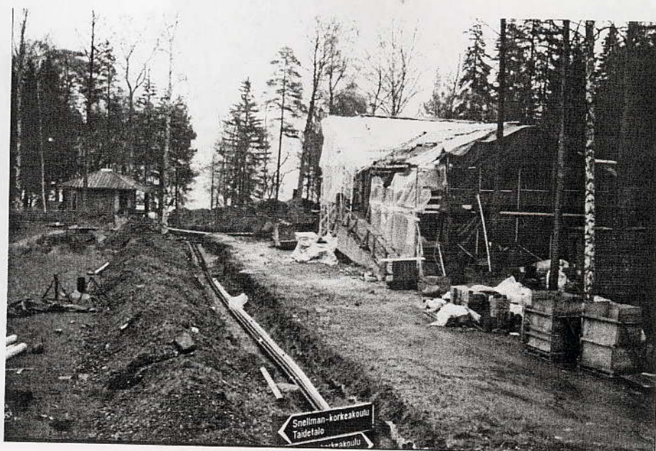
Rakenteet on suojattu sateelta peittämällä ne huolellisesti pressuilla.
