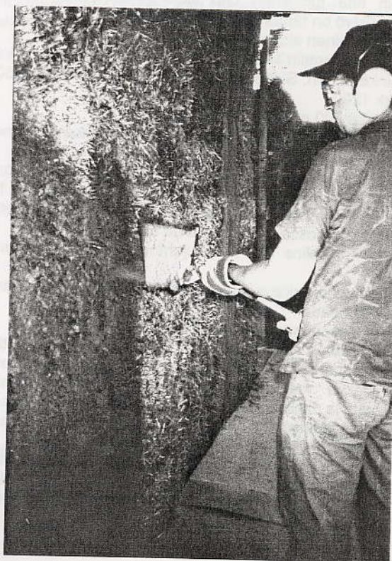
Olkipaaliseinän rappaus täytettävällä rappauslaitteella.
