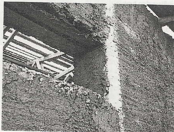
Ikkuna-aukon ylä- ja alareunaan laitettiin tukilaudat vahvistamaan aukkoja. Aukkojen reunat rapattiin
