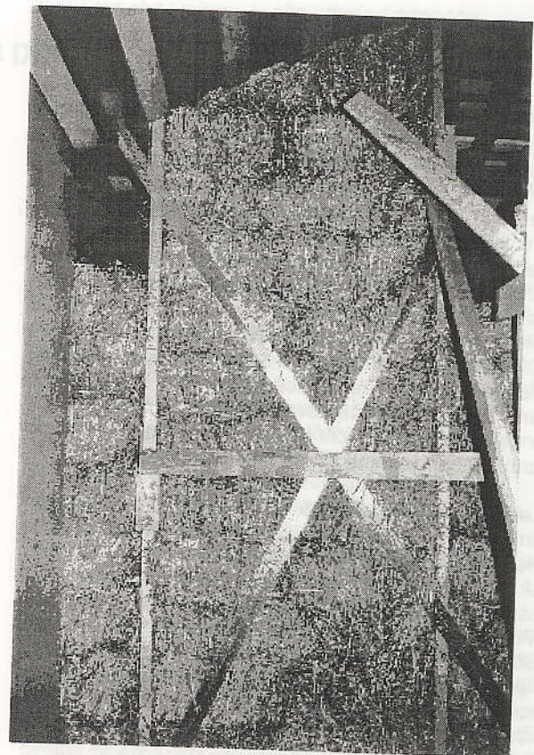
Kuva 4. Snellman kk. Ekoateljee, jonka ulkoseinistä tehtiin puolet olkipaaleista.
