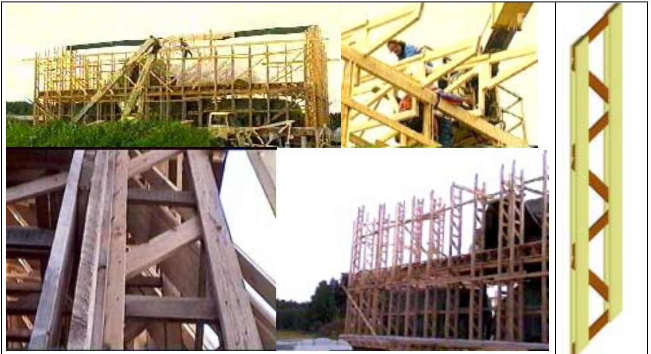
Kuva 17 Viikissä rakenteilla oleva olkipaaleilla eristettävä rivitalo (vas.) ja olkipaalirakenteissa tarvittava puinen tikasrakenne pysty- ja vaakarakenteisiin (oik.)
