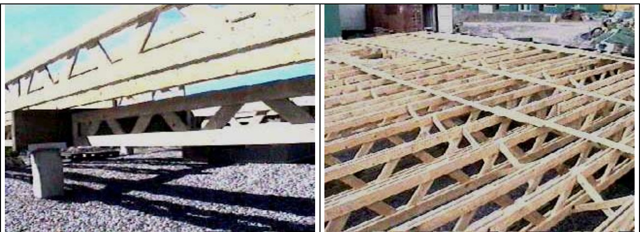
Kuva 9 Oikeaoppinen olkipaalirakennuksen perustus ja tuuletettu alapohjarakenne
