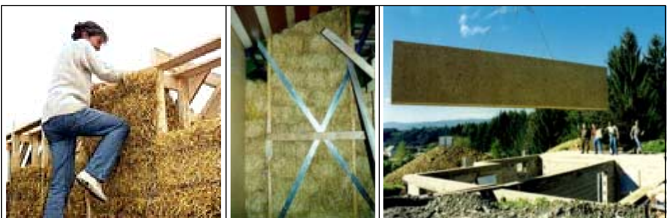
Kuva 18 Olkipaalin asentaminen puurunkoon, teräsnauhalla jäykistetty rakenne ja puurunkoinen seinäelementti /asbn, http://www.baubiologie.at/
