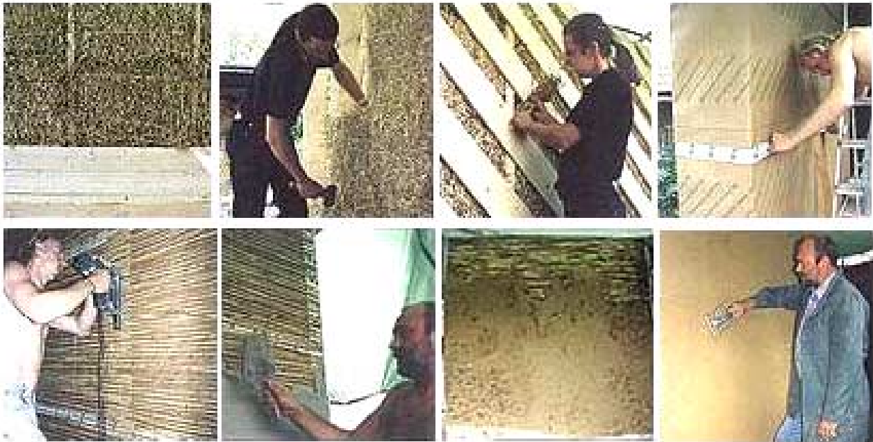
Kuva 7 TU-Wien:in rakentama koeseinäke palokoetta varten. Sisäpinnassa 2 cm savirappaus ja ulkopinnassa 2 cm kalkkirappaus, molemmat ruokomattoon rapattuna /4/
