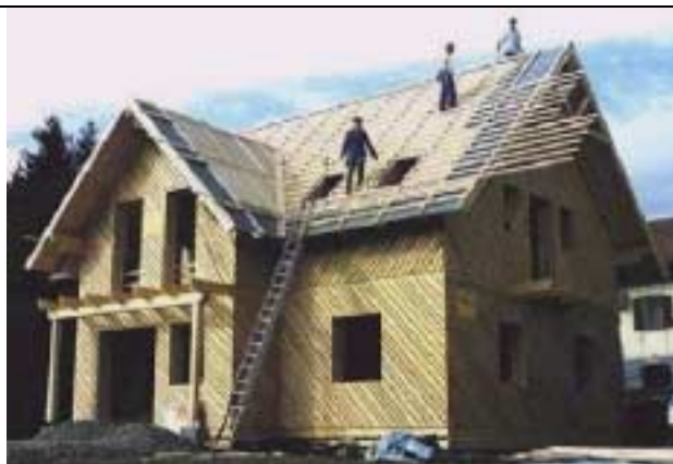
Asuintalo rakenteilla Grazissa (AT), 1999 /4/
