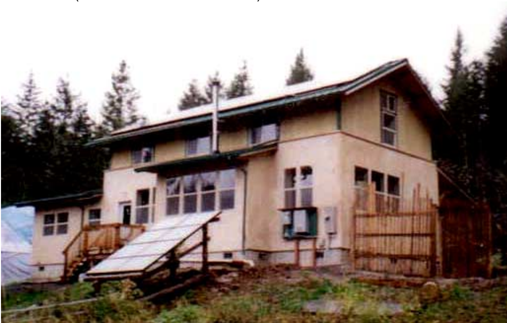
Kuva 10 Yksi kosteusmittauksissa käytetyistä taloista Pohjois-Amerikan länsirannikolla, tutkimuskeskus "Aprovecho" / http://www.efn.org/~apro/strawbale.html /
