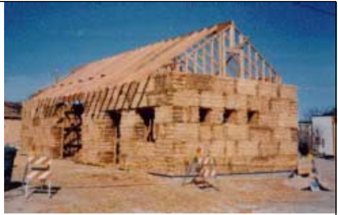
Talo rakenteilla Uudessa Meksikossa (US), 1995
