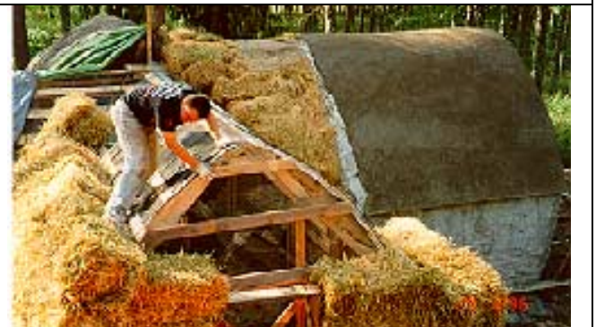
Talo Pellavista rakenteilla Humppilassa, 1996
